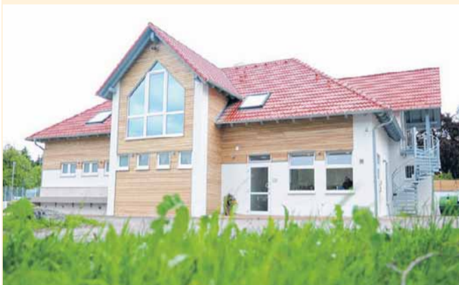
Ansprechend: Das neue Sanitärgebäude von der Südseite.
